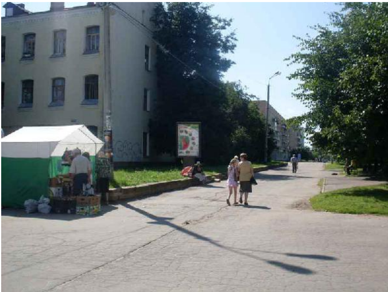
Фото 3. Фрагмент северного и западного фасадов. (2008 г.)
