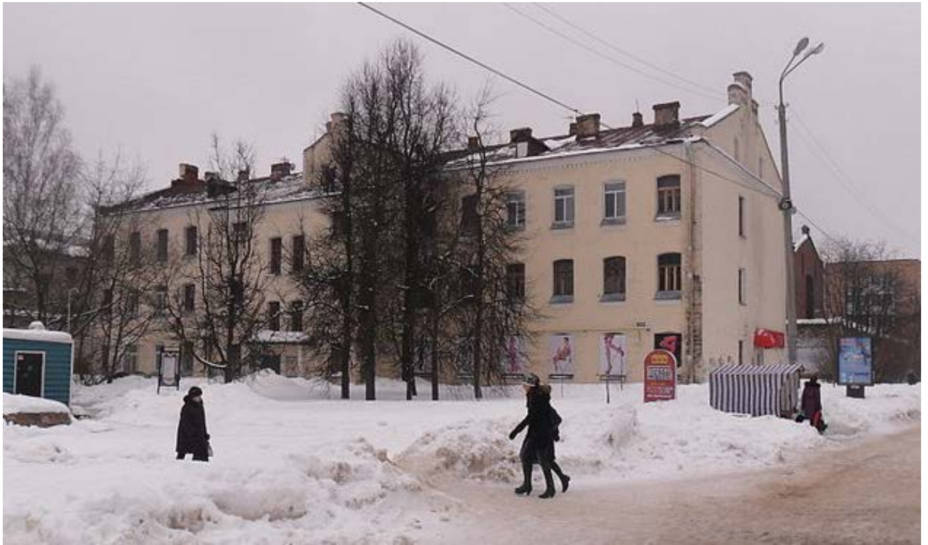
Фото 1. Главный фасад. (2012 г.).
