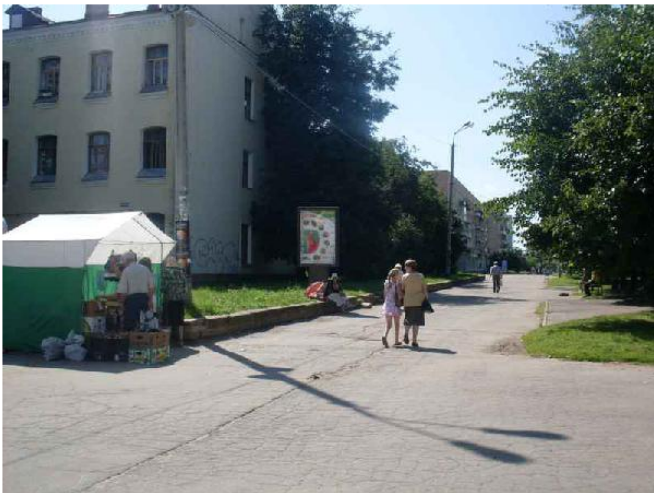
Фото 3. Фрагмент северного и западного фасадов. (2008 г.)
