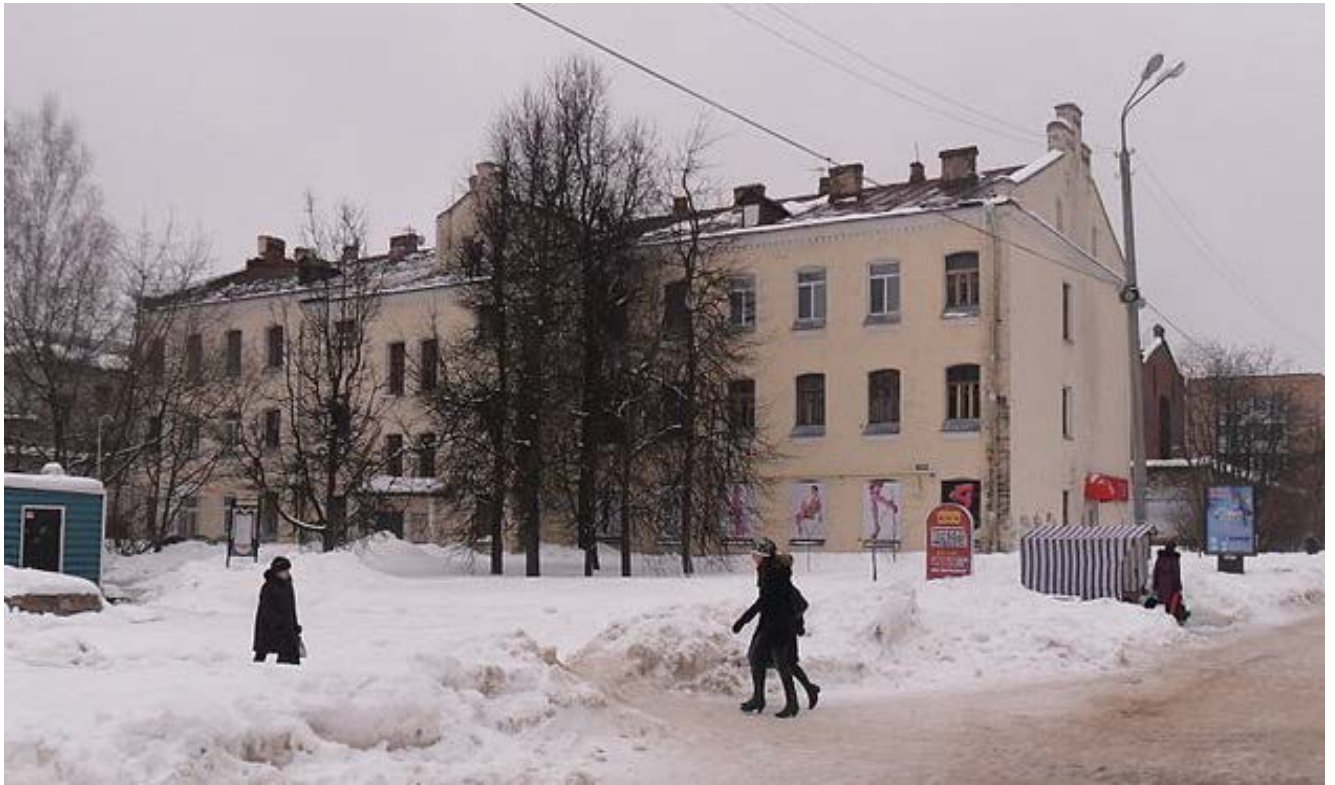
Фото 1. Главный фасад. (2012 г.).
